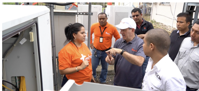
Visita a las instalaciones por parte de nuestros líderes y equipo de técnicos en Panamá.
